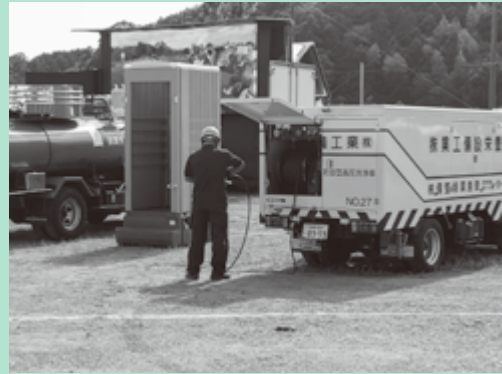
仮設トイレの設置・高圧洗浄車による洗浄
