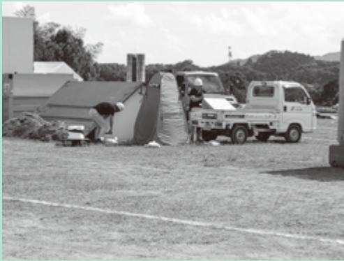
マンホールトイレの設置
