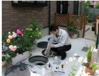
浄化槽の法定検査
